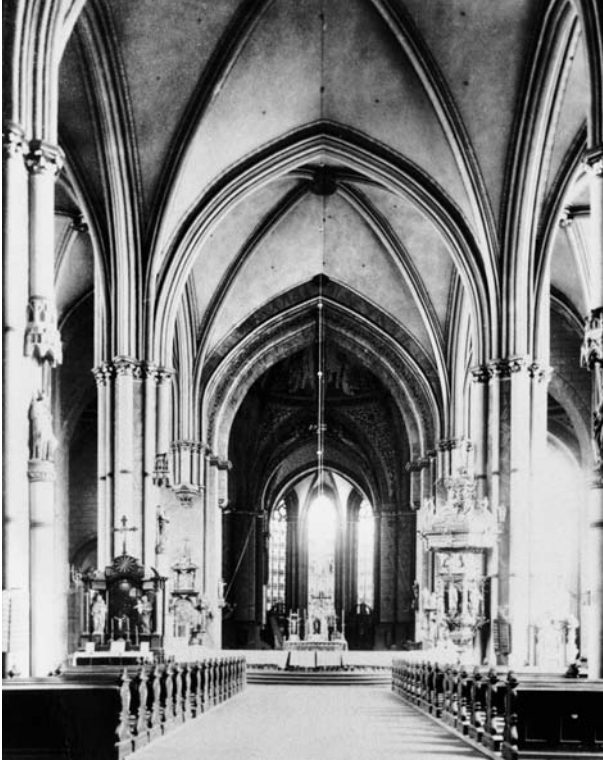
Abb. 2: Blick durch den Dominnenraum nach Osten vor der Innenrenovierung und Kriegszerstörung, 1930
