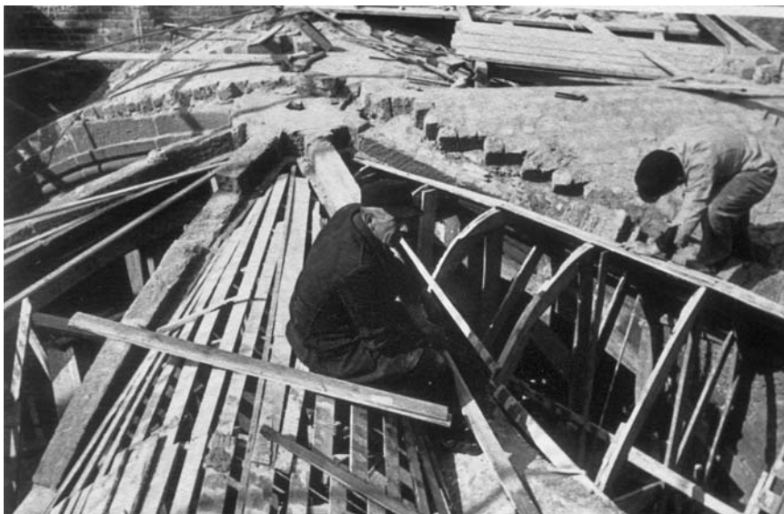
Abb. 18: Auf zwischen den Gewölberippen emporragenden Lehrgerüsten wurden die Seitenschiffgewölbekappen gemauert, 1955.
