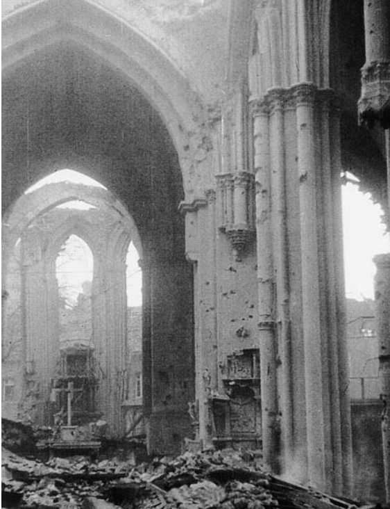
Abb. 7: Der Blick durch das Langhaus nach Osten zeigt links im Bild die noch stehenden Freipfeiler der Südreihe (Ost- und ansatzweise Mittelpfeiler) mit ihren Gewölbekaldächern. Die Aufnahme entstand vor dem 19. Februar 1946.
