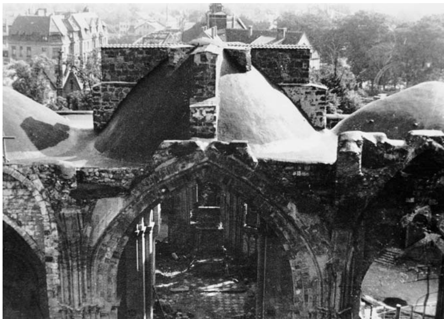
Abb. 9: Die mit Beton abgedeckten Querhausgewölbe in einer Aufnahme vom Gerüst des Westwerks aus. Foto vermutlich vom Sommer 1946.
