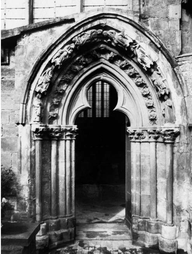
Abb. 19: Das Jungfrauenportal im ursprünglichen Bauzusammenhang im westlichen Volljoch der Südwand. Es gehörte vermutlich zu einer im 13. Jahrhundert nicht mehr ausgeführten Westturmfront und war für diesen Platz nicht optimal gestaltet. Foto 1895.
