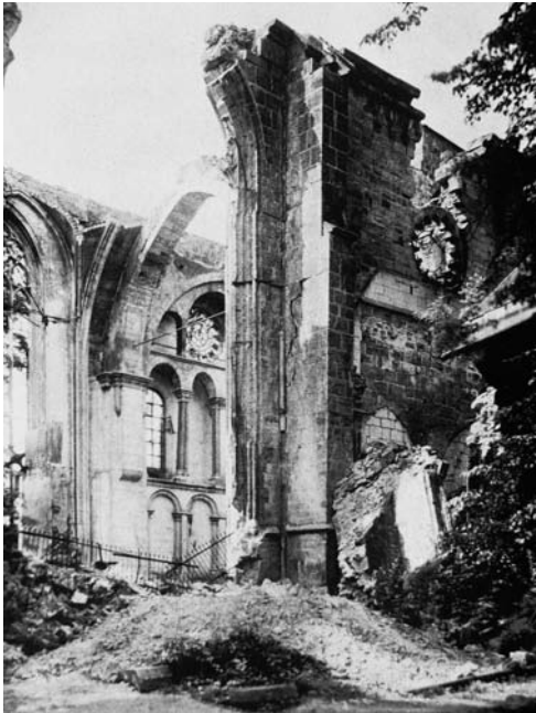
Abb. 4: Das am Nikolaustag 1945 aufge-rissene Chorpolygon und der stark be-schädigte Sakristieanbau von Nordosten in einer Aufnahme von Hans Kastel, 1948. Die Aufnahme wurde auch als Post-karte des DBV produziert.
