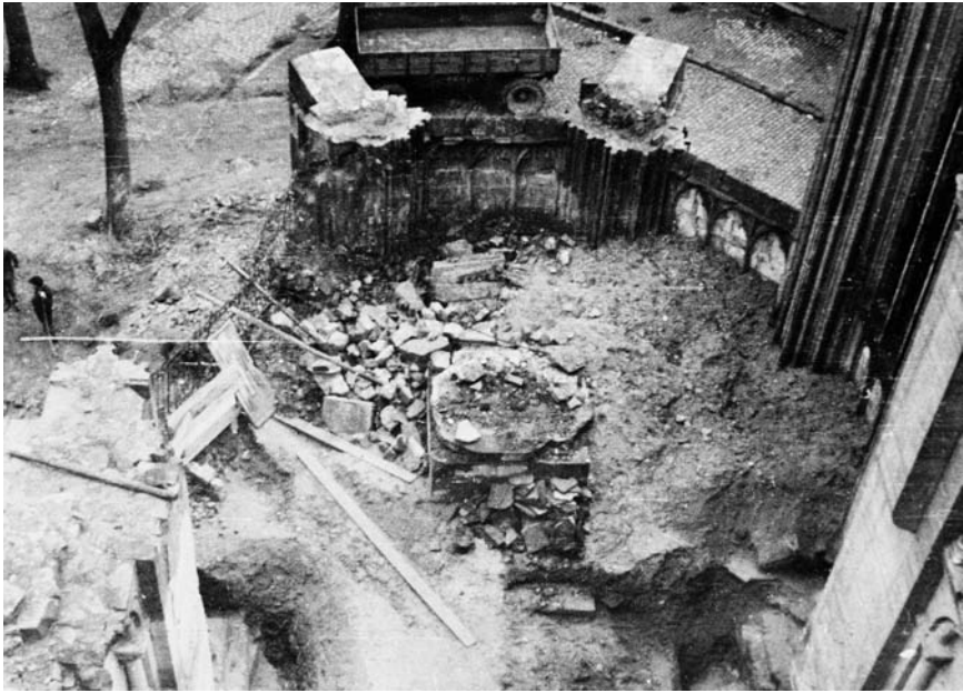
Abb. 14: Vom Vierungsgewölbe aus fällt der Blick auf die nur mehr in Fenstersohlbankhöhe stehenden Polygonwände und der Chorjochsüdwand. In der Bildmitte das Fundament des barocken Hochaltars, unten links und rechts die Ausgrabungen von Esterhues. Foto nach 16. April 1951.
